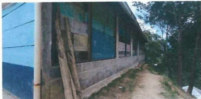
Foto1: En este modulo se tiene ya la construcción iniciada con tres iladas de block. Y en todo el alrededor se encuentra madera. Lado de atrás de las aulas
