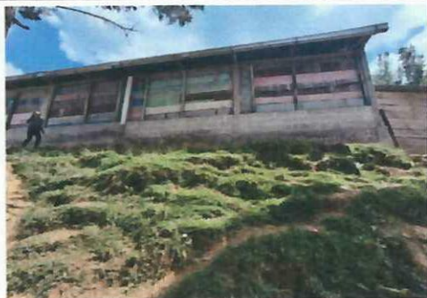
Foto 3: Se necesita refuerzo de muro de las aulas, para iniciar con la colocacion de la sutitucion de pared de madera por block
