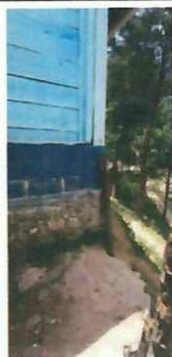
Foto 3: Se necesita refuerzo de muro de las aulas, para iniciar con la colocacion de la sutitucion de pared de madera por block
