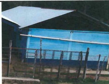
Foto 5: se sustituirá la estructura de techo ya que es de madera y se cambiara por metal en tres aulas que se necesitan
